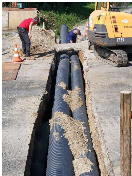
Travaux de prévention contre les phénomènes météorologiques (ici pose d'un réseau pluvial pour éviter inondation route de Saint-Amans)
